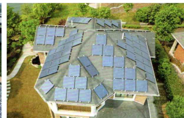
九龙山庄户用屋顶光伏发电项目
