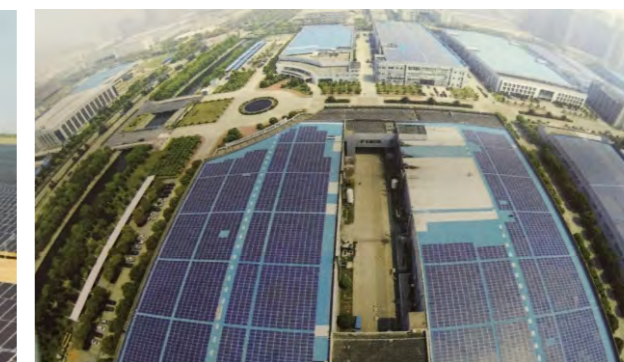
杭州三花集团光伏发电项目
