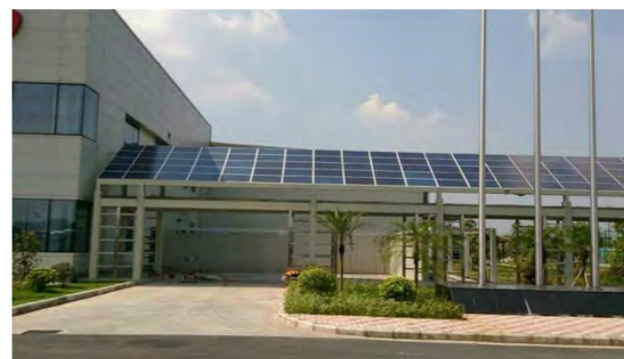
市政建筑屋顶光伏发电示范项目
