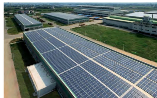
长兴光伏发电示范项目
