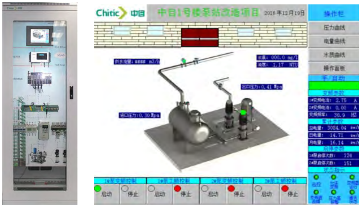
二次供水控制系统及监控画面
